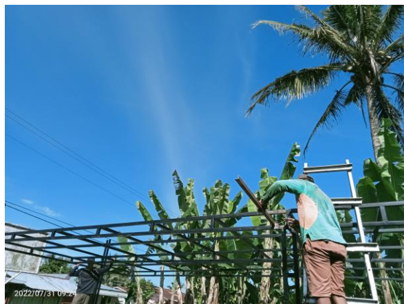
Gambar 2. Proses pemasangan kanopi di usaha mitra
